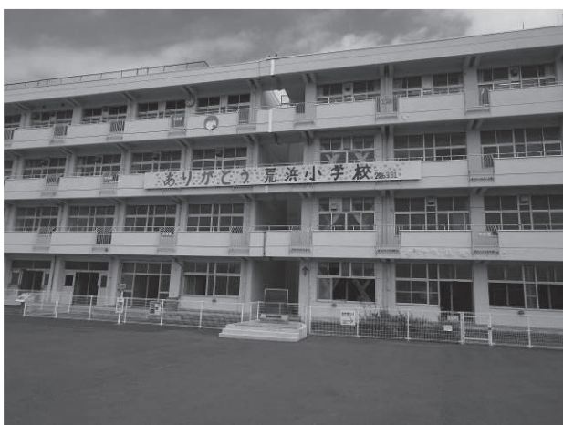
(図10) 震災遺構荒浜小学校
